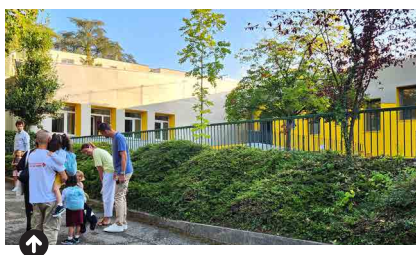
L'isolation de la façade de la maternelle côté cour était achevée pour la rentrée.
