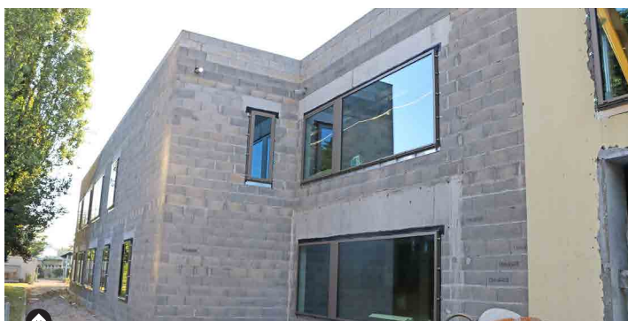
L'extension réalisée à l'arrière de l'élémentaire, dotée de grandes baies vitrées, a permis de redéfinir tous les espaces intérieurs de l'élémentaire.
