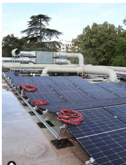
Sur le toit de l'élémentaire, l'impressionnante machinerie de traitement de l'air et la pose en cours, début septembre, des 107 panneaux photovoltaïques.
