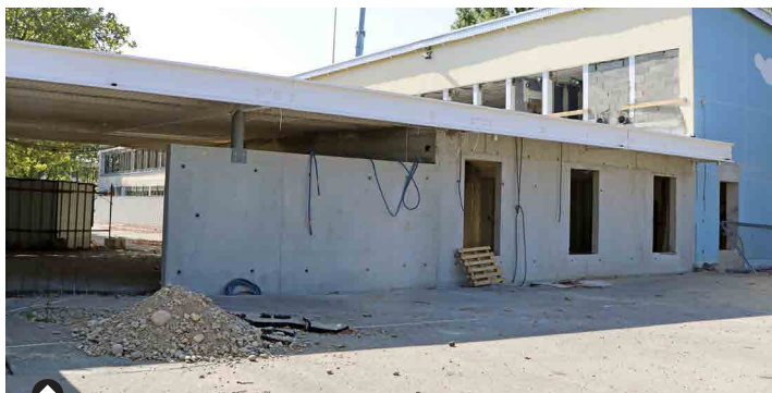
L'entrée de l'élémentaire s'est dotée d'une extension qui accueillera une salle polyvalente et un préau couvert.
