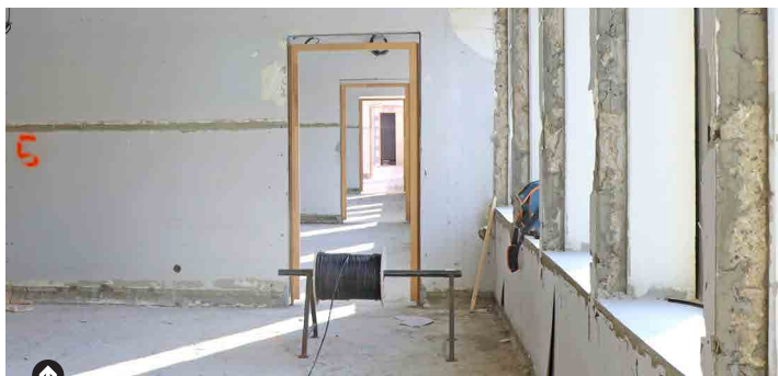
Le nouvel aménagement intérieur permet de disposer de 7 classes de 70 m 2 chacune.
