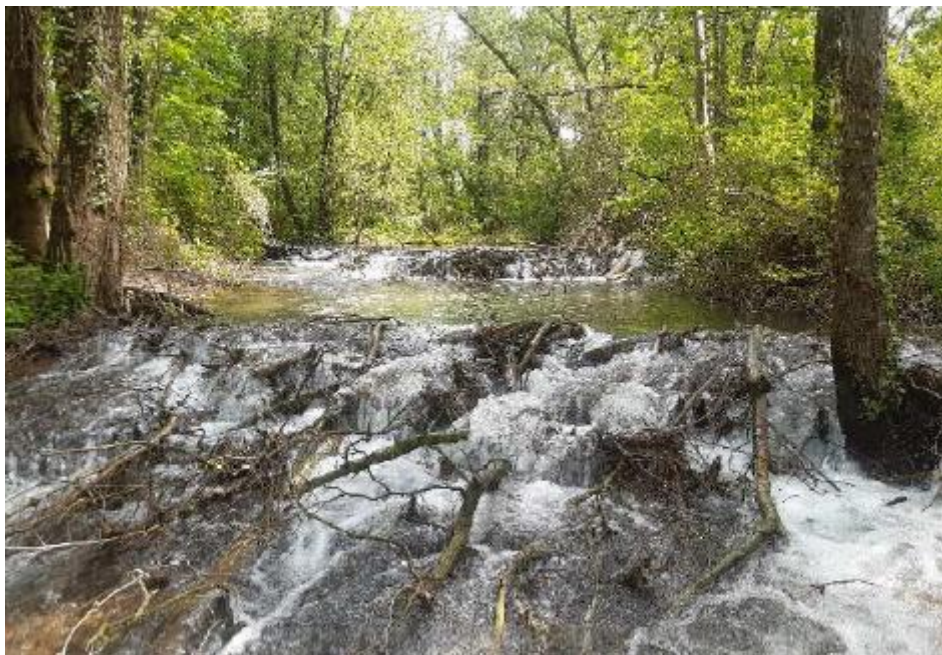
2 ouvrages consécutifs de type ralentisseurs / « barrages »
