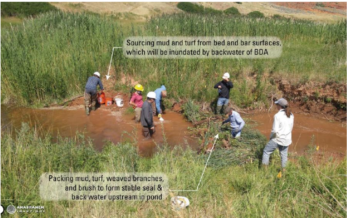
Photo de mise en œuvre d'un ouvrage ralentisseur
