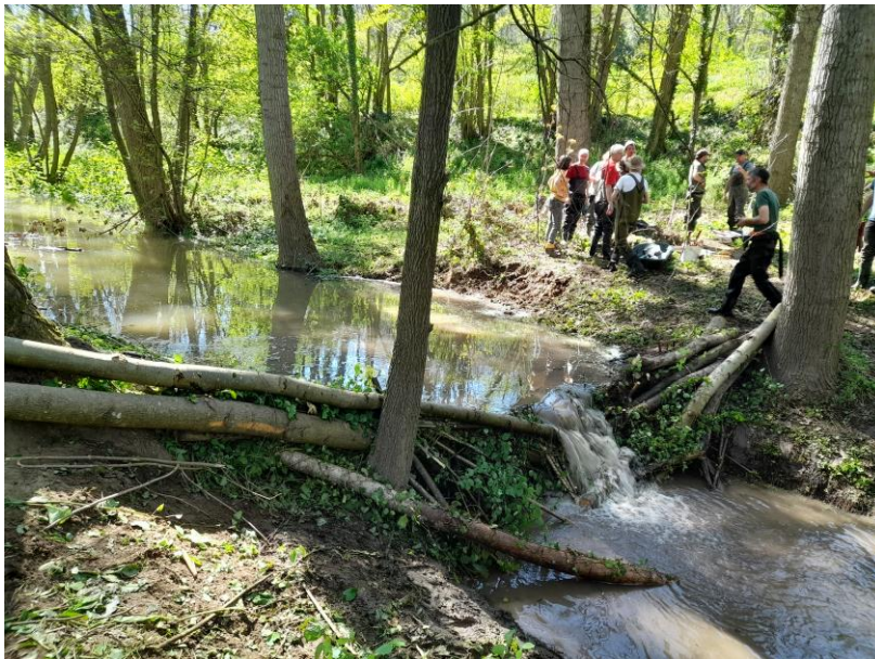
Exemple d'ouvrage ralentisseur type barrage castor – variante avec troncs et ancrage en berge
