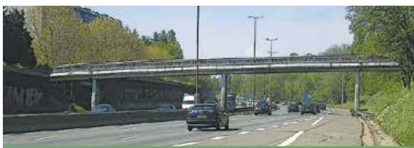
Aujourd'hui la passerelle ne permet que le passage des piétons.
